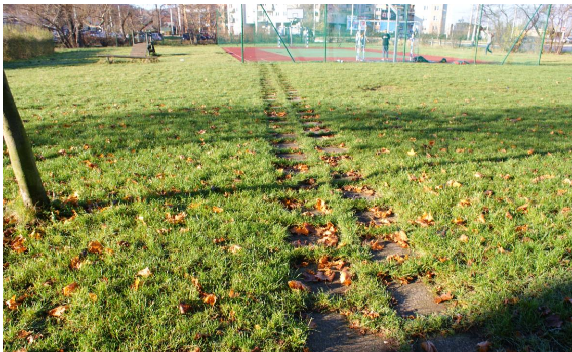
Fot. Istniejąca nawierzchnia do rozbiorki
