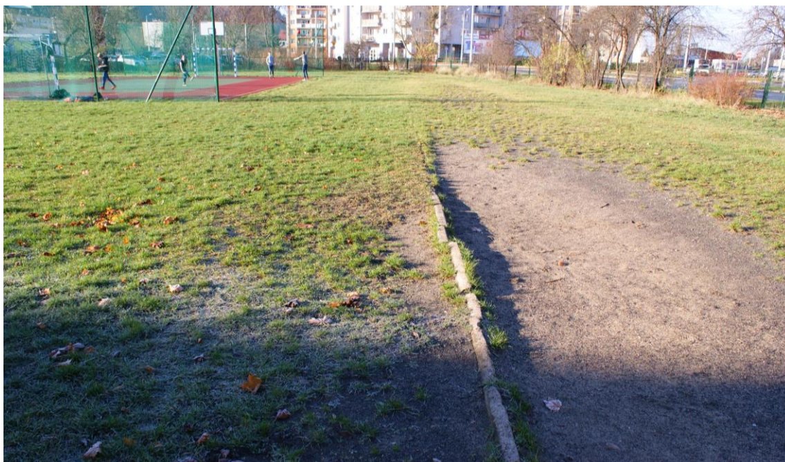
Fot. Istniejące obrzeża do rozbiorki
